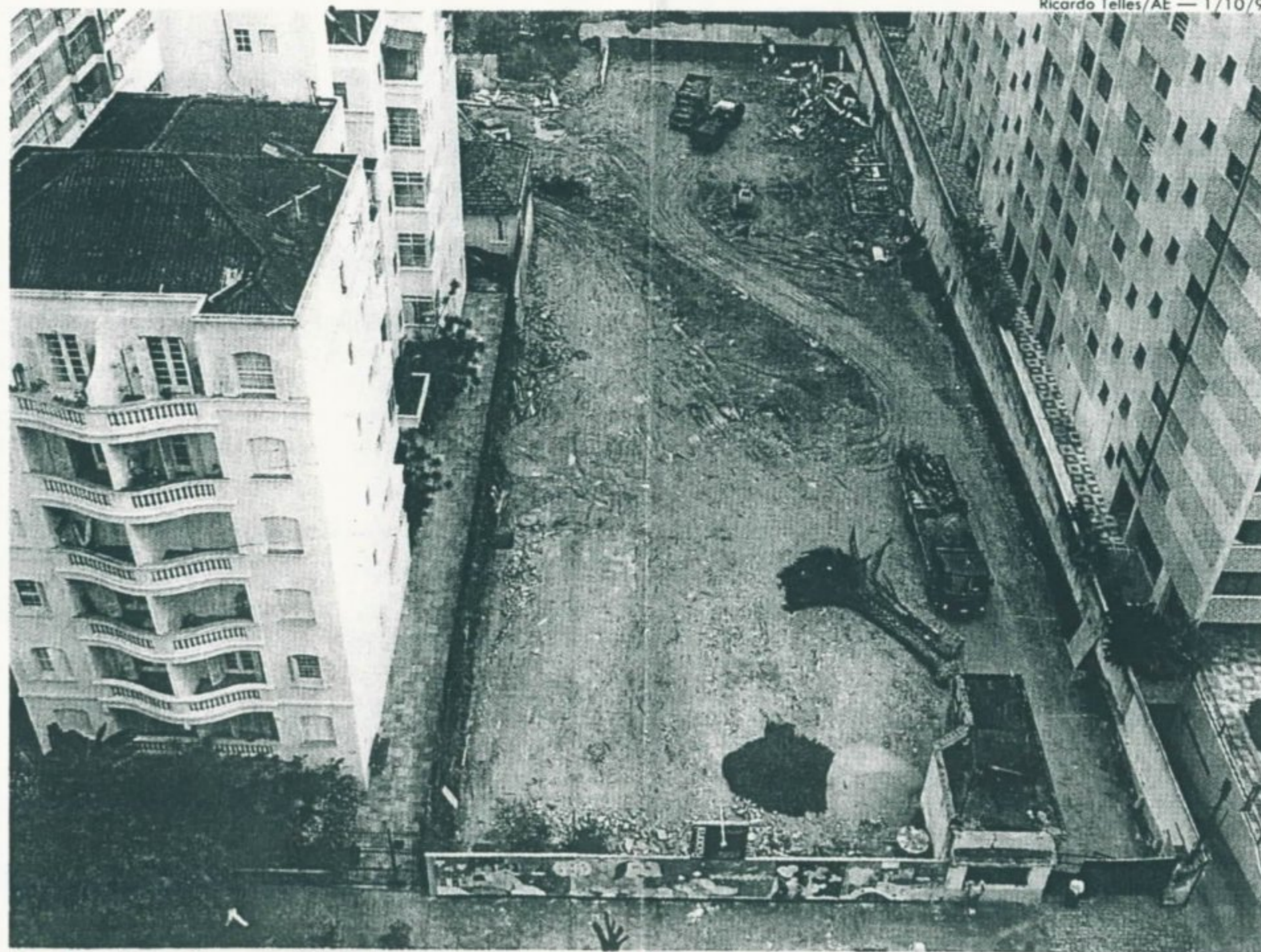
Local onde será construído o shopping no bairro de Higienópolis
